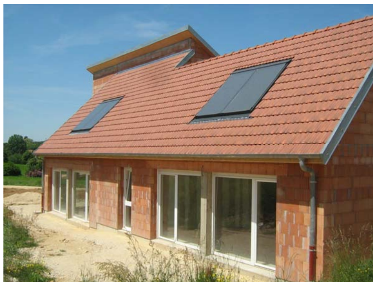
Intégration des panneaux solaires
