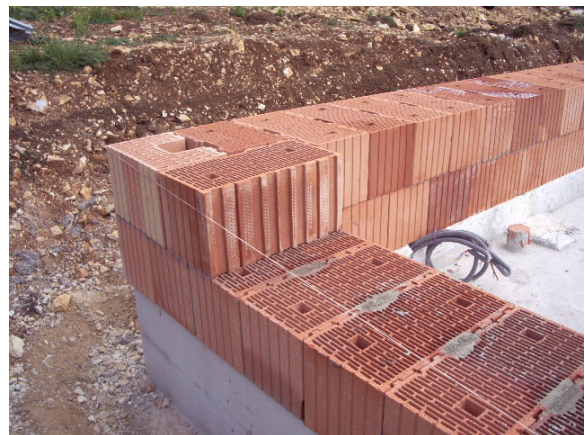
Mise en œuvre de la deuxième rangée
