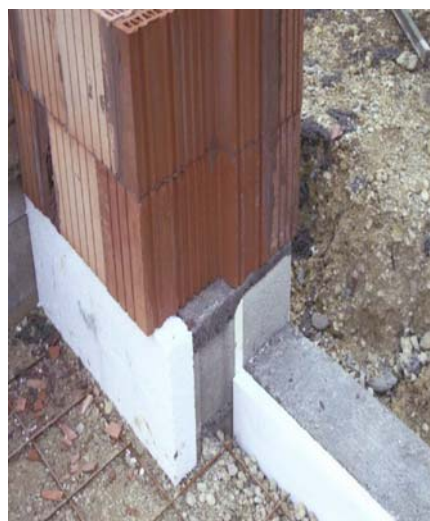
Isolant thermique (80 mm) en périphérie de dalle
