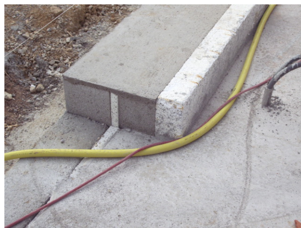
Isolant thermique (80 mm) en périphérie de dalle
