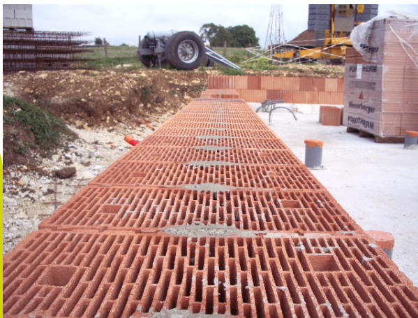
Briques monomur avec poches à mortier remplies
