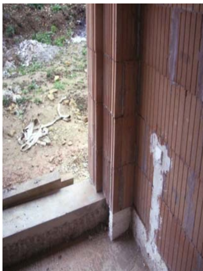
Saignée verticale dans le mur
