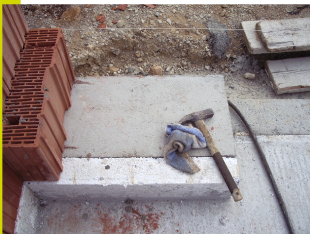
Isolant thermique (80 mm) en périphérie de dalle
