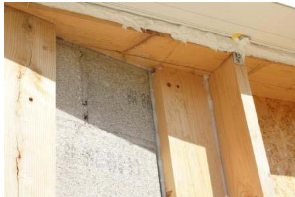
Détail de structure : lien maçonnerie / verrière
