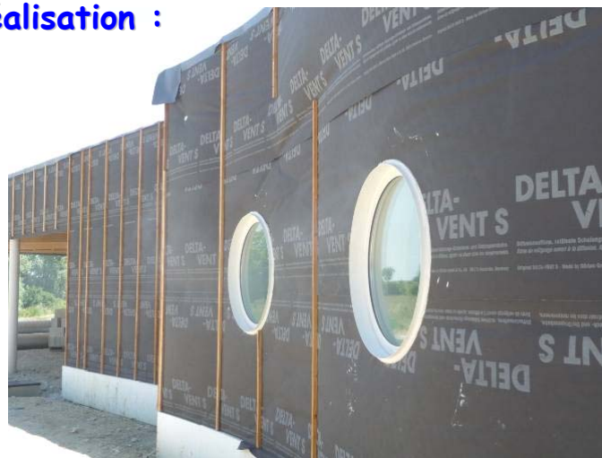
Mise en œuvre du Pare Pluie
