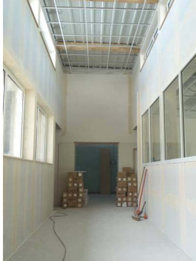
Mise en œuvre faux plafond
