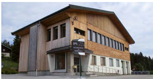
Rénovation de la mairie salle des fêtes Commune de Nanchez (39) Maîtrise d'œuvre SIDECE
